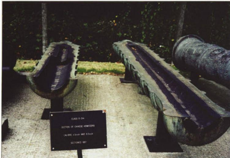
图版 15 两门中国青铜-铁炮的纵截面
