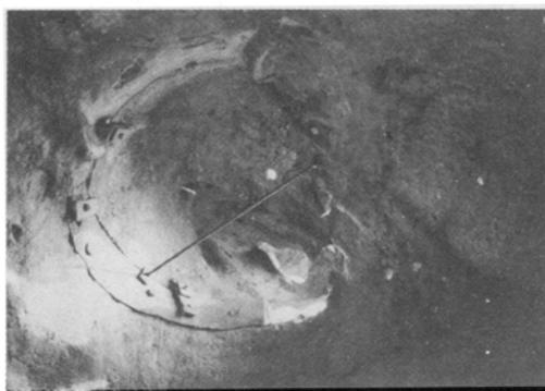
图 18 沧州铁狮子头的内部 (作者摄) 显示有更多现代修复的部分。从照片中可以看到浇铸中用于加固的锻铁从照片的中心向右下方延伸
